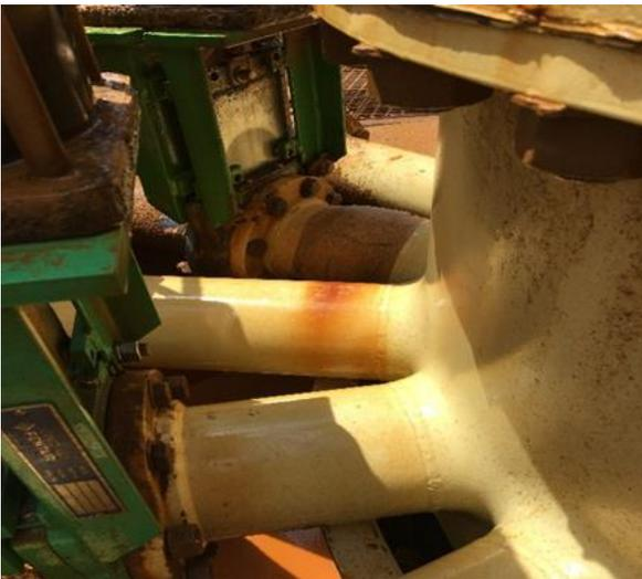
**200mm SLURRY POLY LINE ELBOW**
